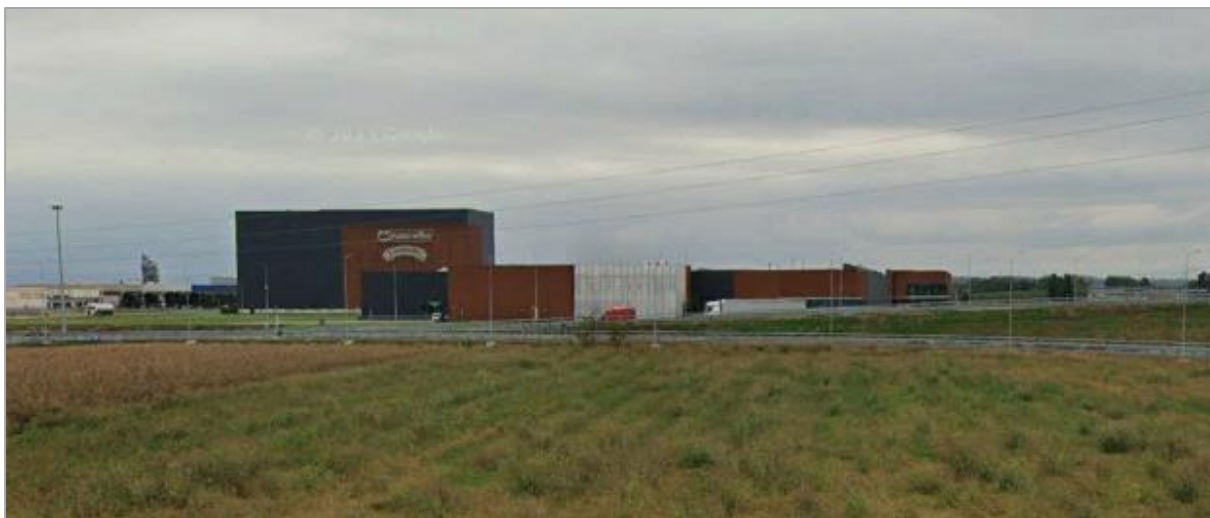
Figura 4.1.2/4 - Modifica 1 PROD – Vista dello stato attuale dello stabilimento Panealba dalla SP 662 all'altezza del casello dell'autostrada A6
