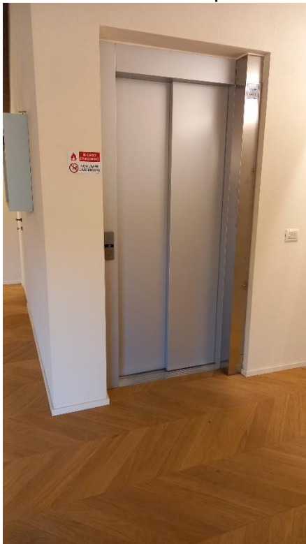
Ascensore per accesso ai piani – post restauro
