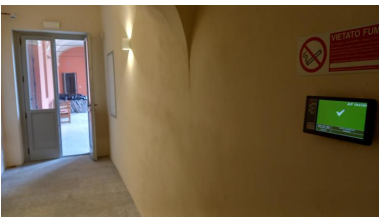
Porta verso il cortile – post restauro
