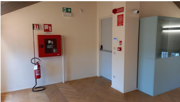
Uscite di sicurezza – post restauro
